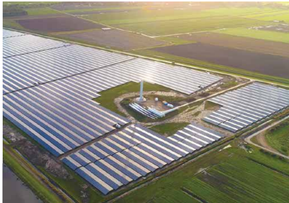
Duurkenakker Solar Power Plant
